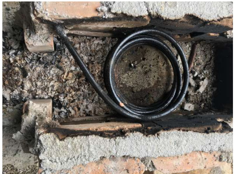
Wasserführendes Kupferrohr bei abbau des Ofens
